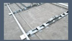
■ 施工図を参照し隅出しを行った後、 ベースレールを連結します。
