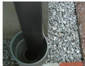
雨水配水管処置 縁切りにより配管の破損を抑止
