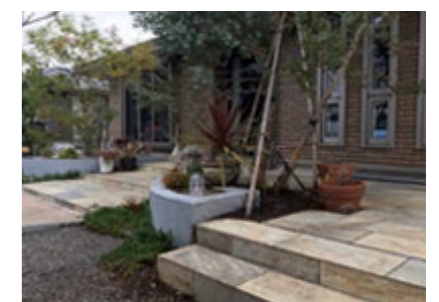
▲玄関アプローチの敷石の土台
