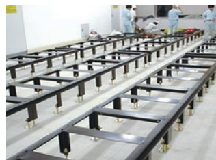
■架台の設置・施工
