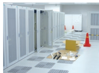
■サーバーラックの設置・施工
