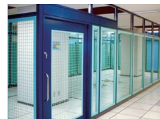
■セキュリティケージの設置・施工
