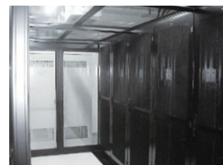
■コンテインメントの設置・施工
